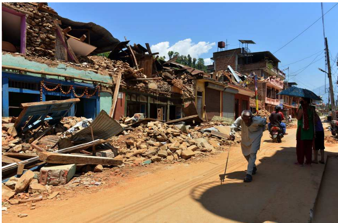
Weg der Zerstörung: Nepalesen gehen an eingestürzten Gebäuden in Trishuli nördlich von Kathmandu vorbei. (4. Mai 2015)
